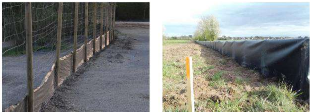
Exemple de dispositifs de mise en exclos de chantier pour la petite faune Photos : Eliomys
