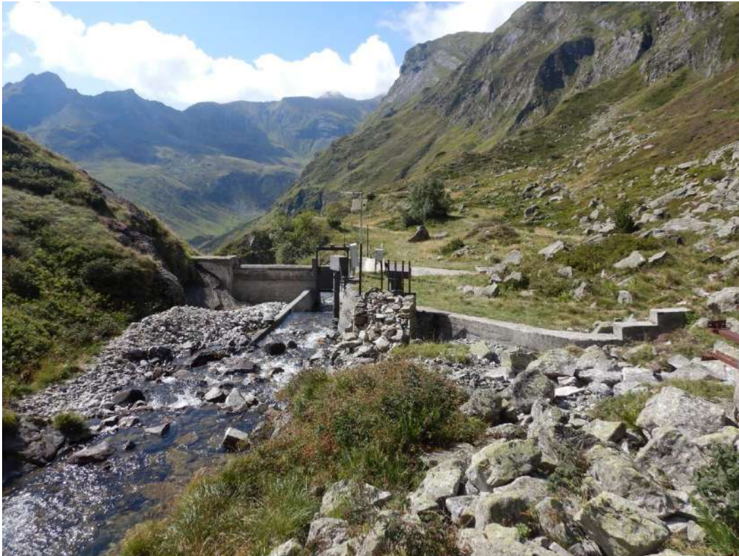
Chap. II - Figure 8 : Prise d'eau EDF sur le Gave de Cestrède (source : Artelia, 2019)
