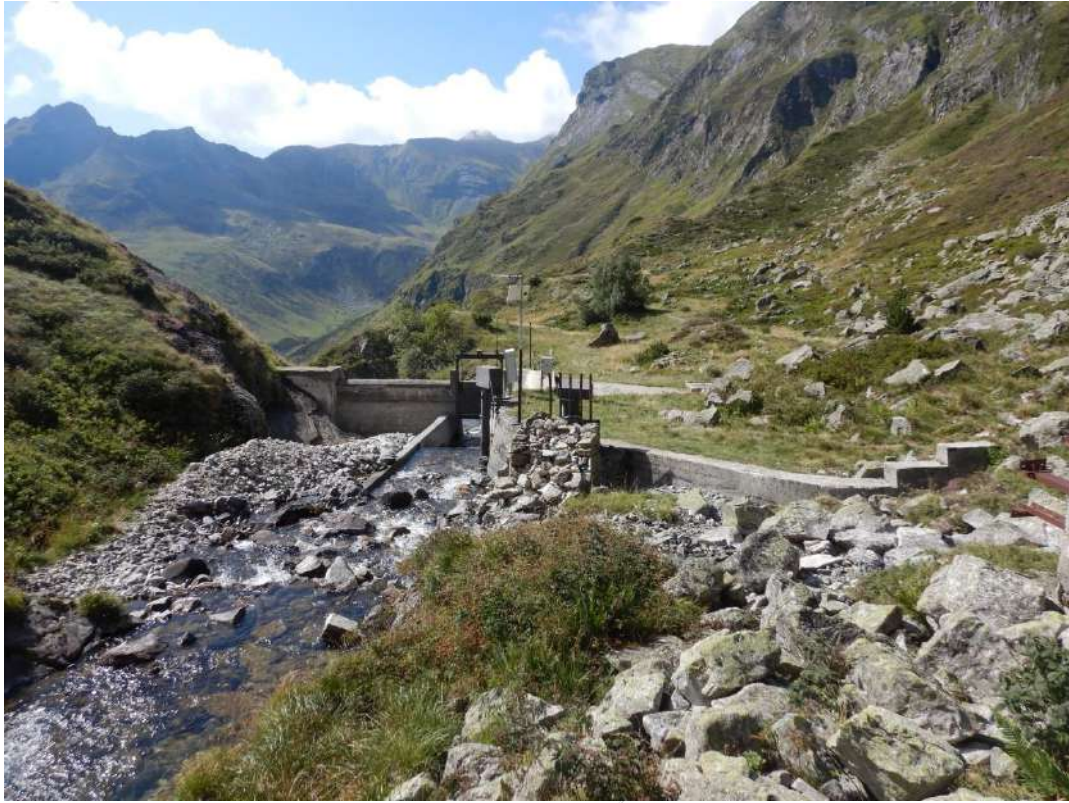
Chap. XI - Figure 13 : Prise d'eau EDF sur le Gave de Cestrède (source : Artelia, 2019)
