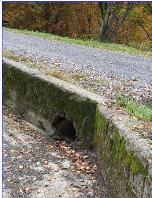
Chap. IV - Figure 33 : Passage busé sous la piste (source : Amidev, 2018)
