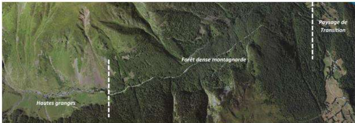
Chap. IV - Figure 125 : Vue aérienne des unités paysagères traversées (source : Artelia, 2020)
