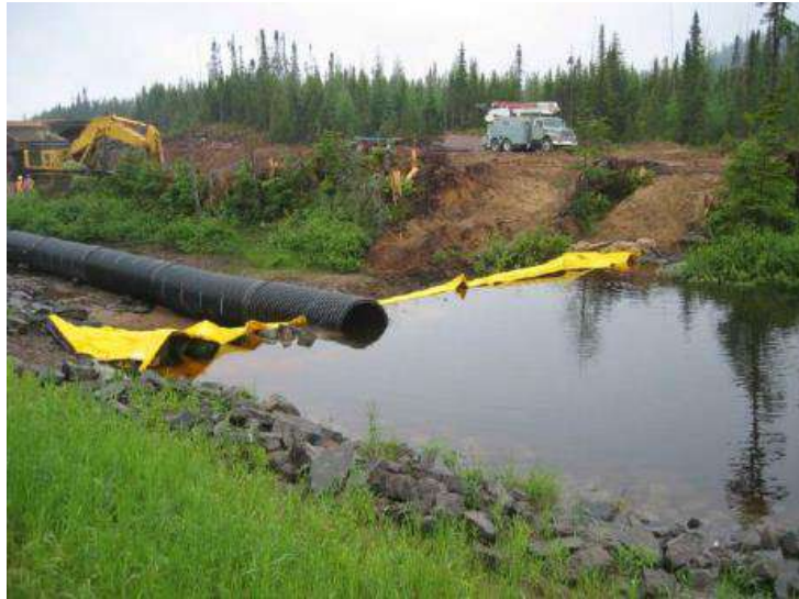
Chap. II - Figure 33 : Exemple de disposition pour dérivation provisoire de l'écoulement
