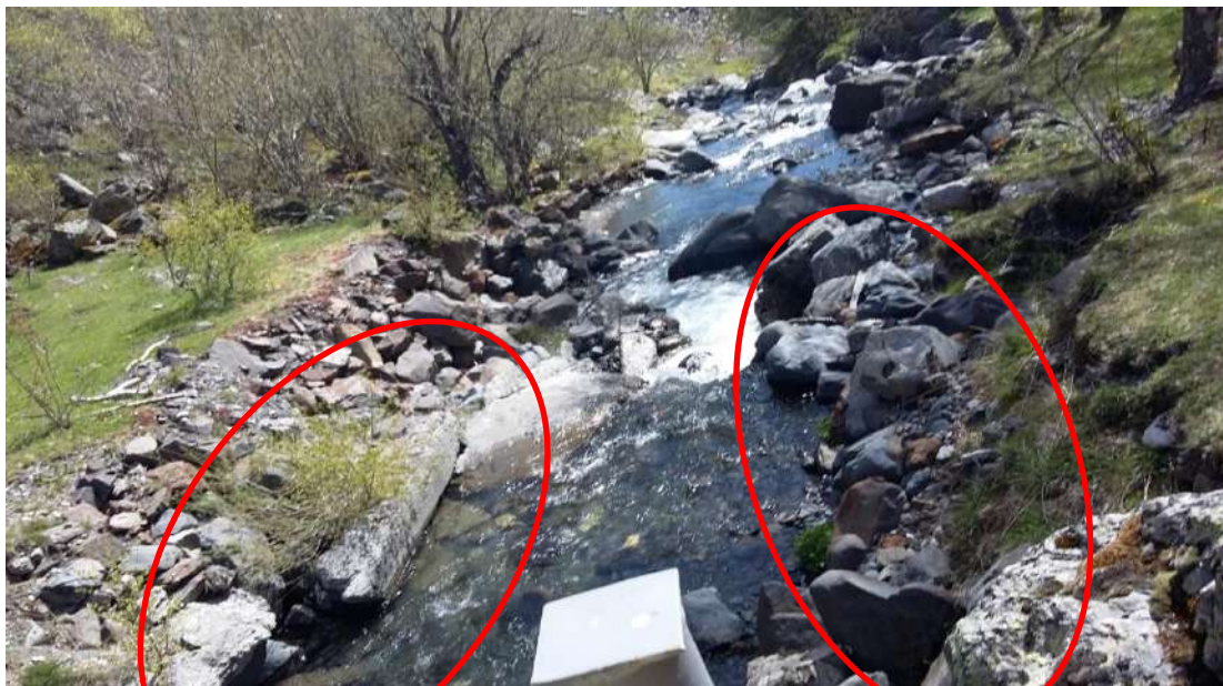
Chap. XI - Figure 25 : Prise de vue du site : zone d'implantation de la future prise d'eau (vue depuis la passerelle à laquelle la prise d'eau sera accolée, en aval immédiat)
