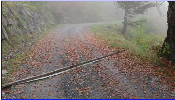
Chap. IV - Figure 34 : Revers d'eau sur la piste d'Ayrues (à gauche) et passage busé et sur-largeur de piste (à droite) (source : Amidev, 2018)
