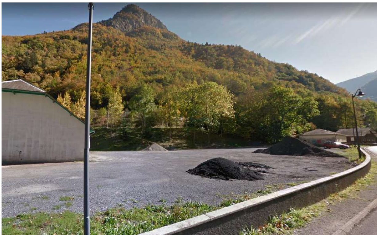
Chap. II - Figure 29 : Photo de la zone de stockage 1
